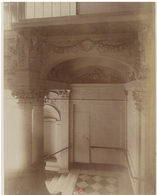
Ил. 15. Эжен Атже. Вестибюль и лестница
