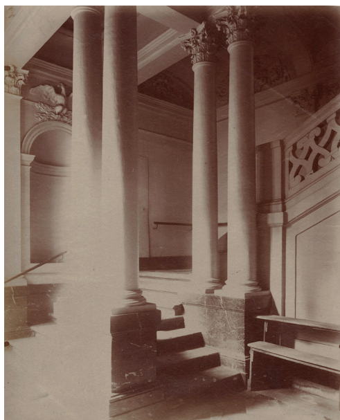
Ил. 13. Эжен Атже. Вестибюль и лестница
