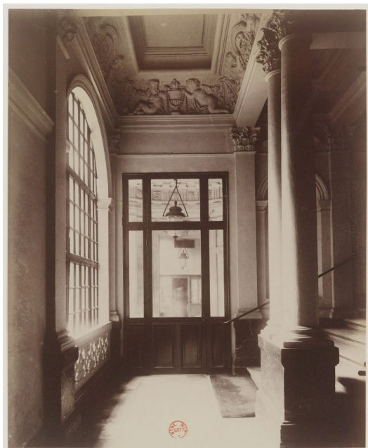
Ил. 12. Эжен Атже. Вестибюль и лестница
